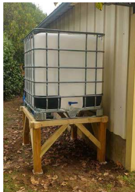
Rezervor pentru stocarea apelor pluviale.
